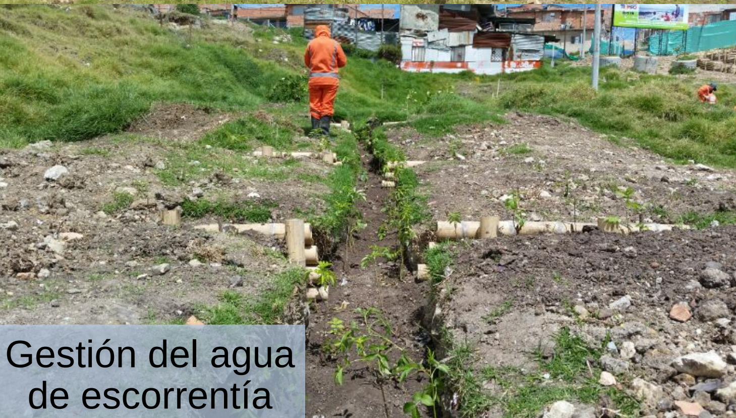
Recuperación de áreas erosionadas con trinchos
